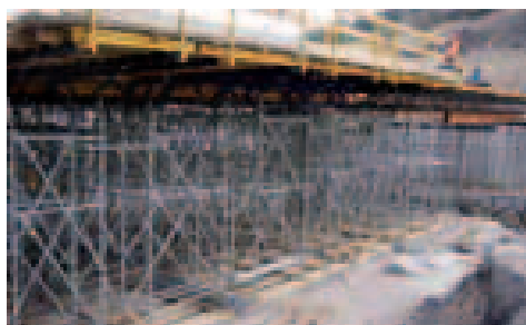
Apeo de tablero de puente mediante la Cimbra BRIO
