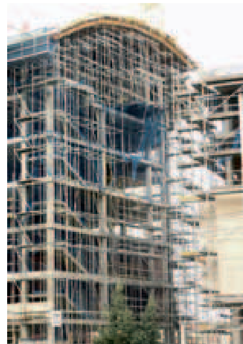
Edificio de viviendas apeado con Cimbra BRIO en Cornellá, Barcelona, España
